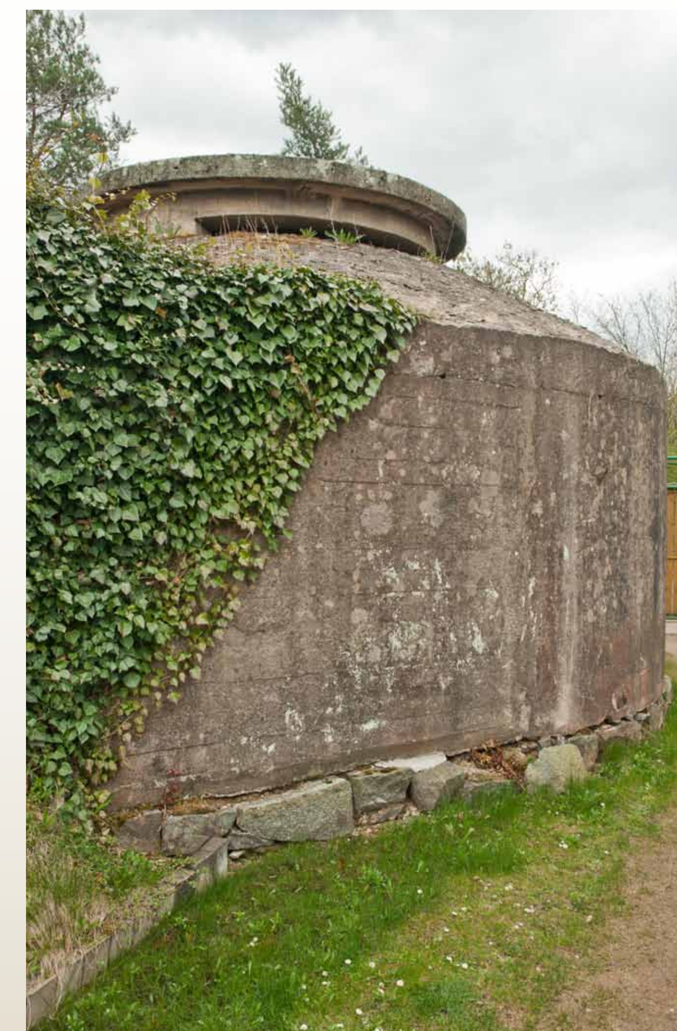
▲ Vojenský bunkr na Sekance má střílny vymodelované v betonu a dvě zvonové šachty zakončené pozorovacími šterbinami. (Foto: V. Pavelčík)
