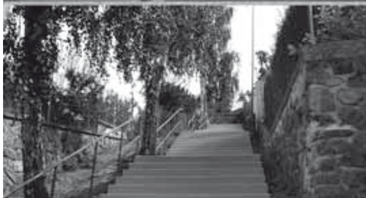
V letních měsících proběhla rekonstrukce horní poloviny schodů na Ovčičky. Výrazně se tak zvýšila bezpečnost chodců při cestě z horní části Brunšova do Štěchovic.
