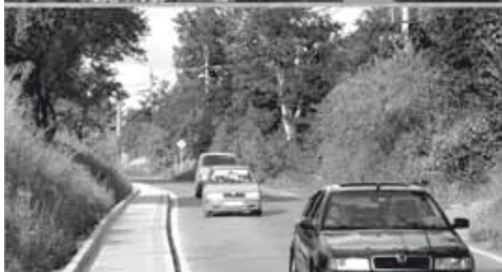
Rajchardovští se konečně dočkali tolik potřebného chodníku (zatím bez osvětlení). Po dokončené 1. etapě bude výstavba pokračovat prodloužením trasy z Rajchardova do Hradištká.
