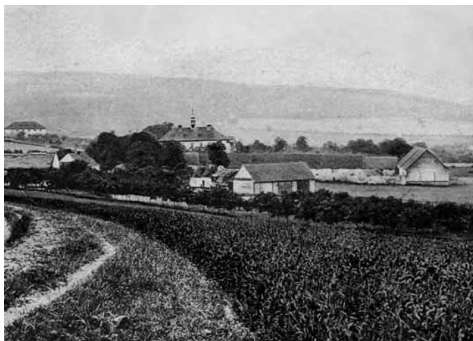
Pohled na zámek od severozápadu
